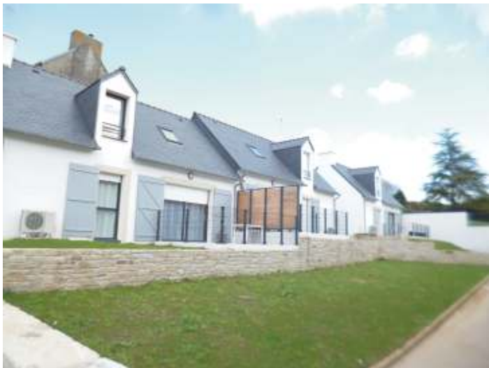
Locatifs occupés depuis décembre 2020 T3 (partie basse)
