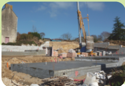
Travaux en cours
